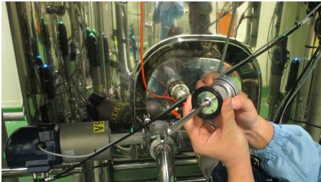
タンク・配管等の温度・圧力センサー 付け根の検証
