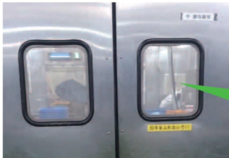
スイング扉の窓を網戸にすることで、意図せず製造・加工室間で差圧が発生した場合も、開放状態にならないように工夫した例。
