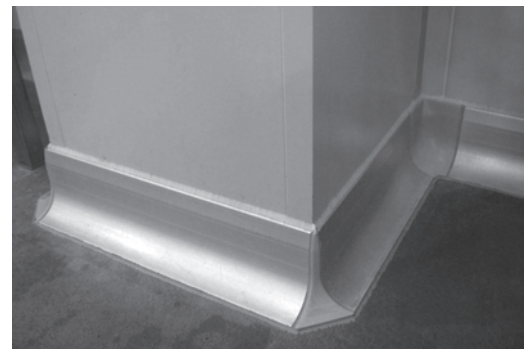
床と壁の間のR取り
